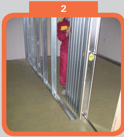
Usazení pouzdra do spodního profilu SDK
