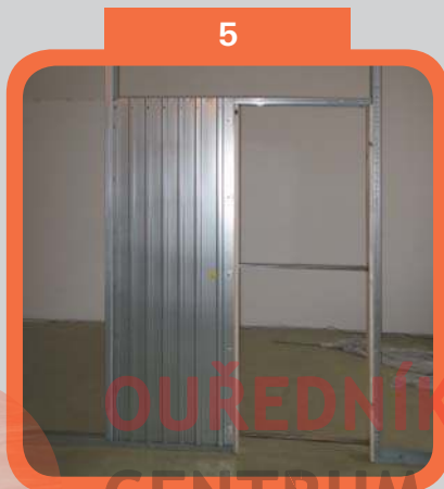
Usazené a zabudované pouzdro v konstrukci
