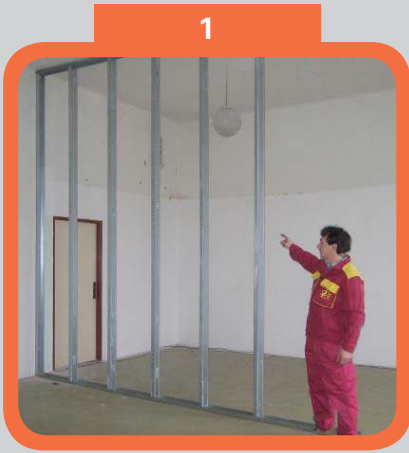
Příprava profilů SDK pro usazení pouzdra
