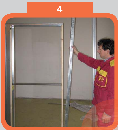
Montáž protilehlé strany konstrukce
