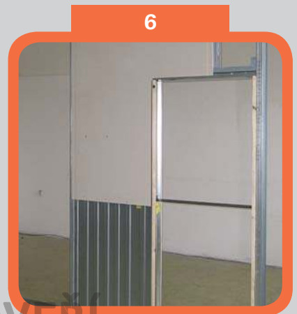
Opláštění pouzdra deskou SDK
