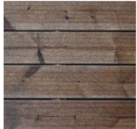
Terasové profily ve fázi začínajícího procesu šednutí. (přirozené jsou mapky připomínající vznikající plíseň)
