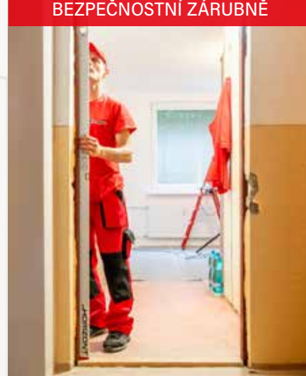
USAZENÍ NOVÉ BEZPEČNOSTNÍ ZÁRUBNĚ
