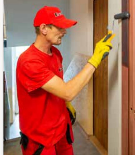
NÁTĚR NOVÉ ZÁRUBNĚ
