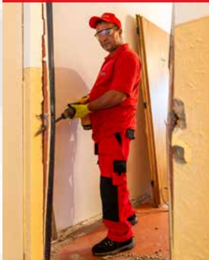
BOURÁNÍ STÁVAJÍCÍ ZÁRUBNĚ
