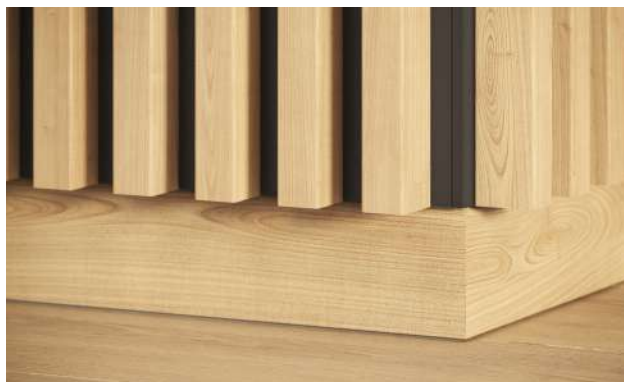
ukázka ukončení dekoračního panelu nad podlahovou lištou
